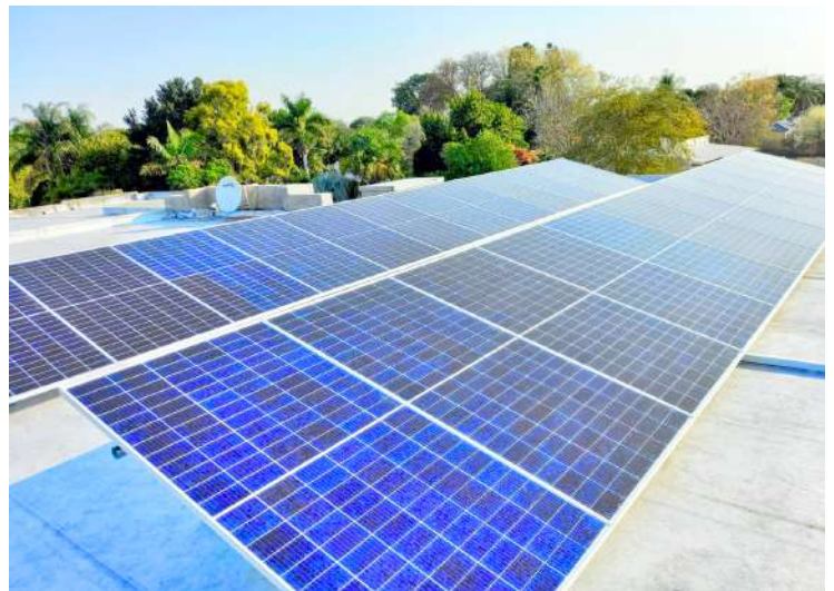
30kW Mini-Grid (Roof Top)
